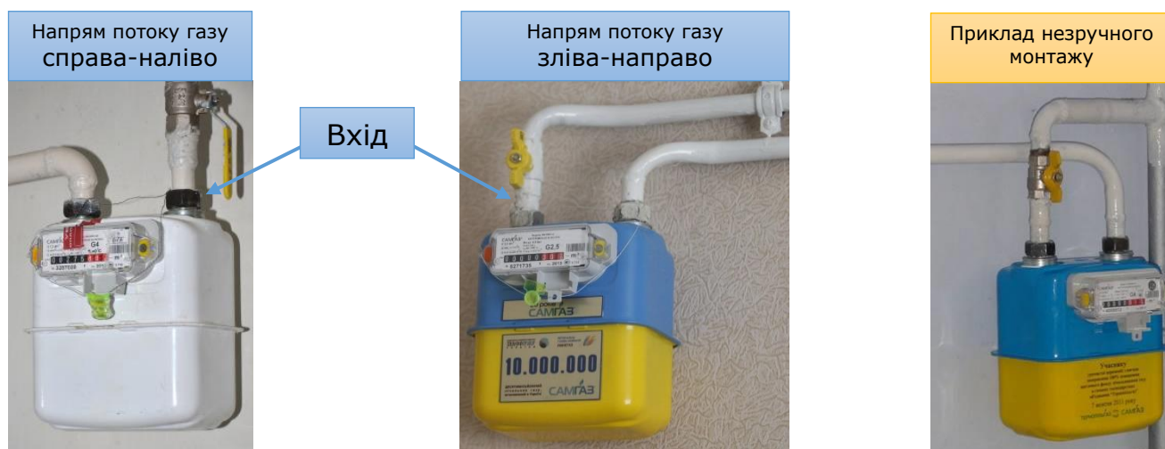
Рис. 8 Приклади монтажу лічильників газу
